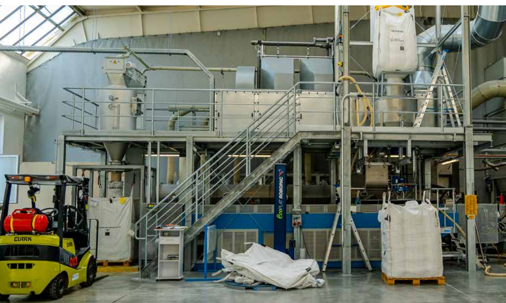
Eine der modernsten Verarbeitungsanlagen auf dem Gelände der IKA.
